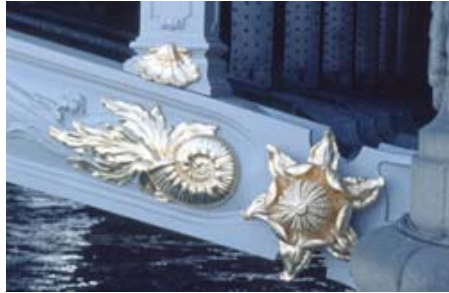
ornement de fonte : motifs marins après restauration, dorés à la feuille
